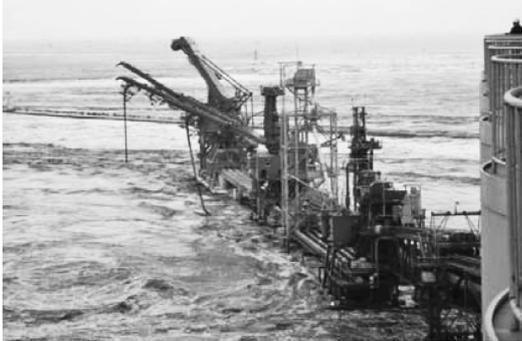
写真6 本船船先激突により棧橋破損
