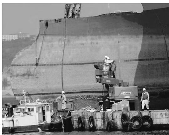
写真9. 底部塗膜剥離作業
